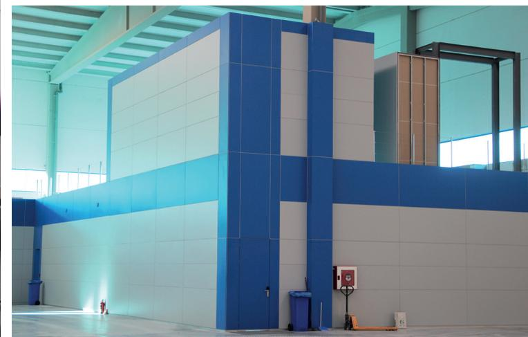
Mamparas compuestas por doble panel de tablero en multitud de acabados diferentes con una estructura interna de aluminio y relleno de lana de roca en su cámara interior. Rodasuelo y rodatecho de aluminio anodizado visto. Los diferentes paneles están separados por juntas horizontales y verticales de 10mm PVC, pudiendo escoger libremente el número de separaciones y paneles.
