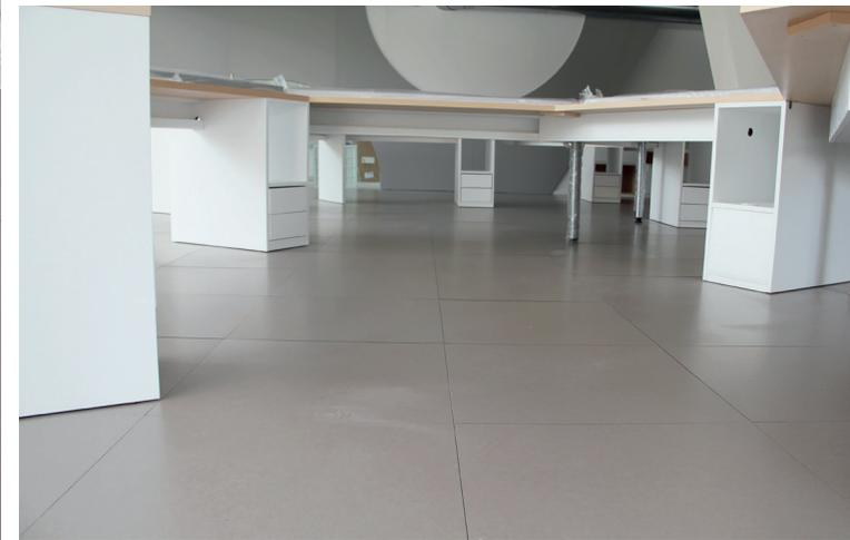
Pavimentos elevados registrables que permiten el acceso a las instalaciones técnicas por debajo del mismo. El núcleo de la placa de suelo se puede componer de aglomerado de alta densidad, sulfato, cemento, etc. El acabado superficial también se puede realizar con vinilo, madera, gres, porcelánica, piedra natural, etc. Los pies que levantan y nivelan las placas pueden ser de acero galvanizado o de PVC para exteriores.
