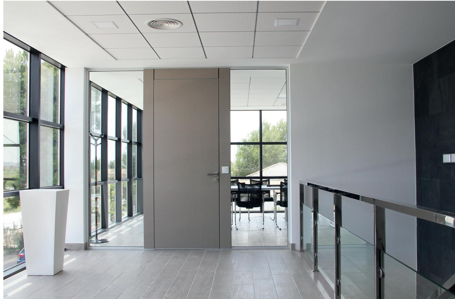
Diseñadas para conseguir un excelente aislamiento acústico y quedar enrasadas por ambas caras de las mamparas de oficina, sin necesidad de utilizar marcos, quedando integradas perfectamente en el conjunto. Su espesor de 8cm y estructura de aluminio las dota de una elevada estabilidad dimensional y evita deformaciones y alabeos. El interior está relleno de lana de roca. En su modelo estándar, están equipadas con cerradura magnética.
