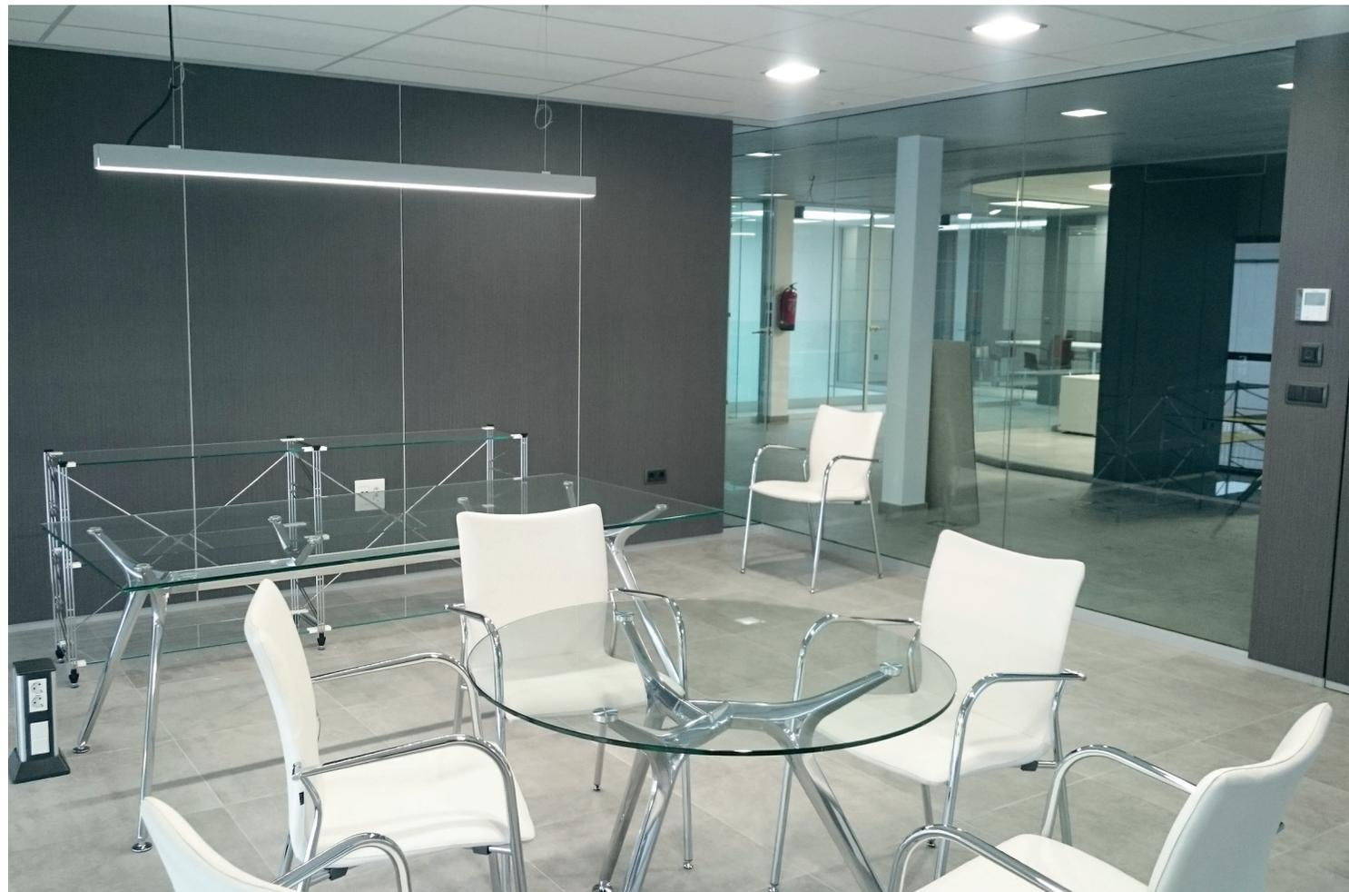
Rodasuelo y rodatecho de aluminio anodizado visto con paneles de tablero en ambas caras. Los diferentes paneles están separados únicamente por juntas verticales de 10mm PVC. La cámara interior entre los paneles se rellena con lana de roca para lograr un adecuado aislamiento acústico. Si la altura total de la mampara lo requiere, las mamparas V-Line incorporan una junta horizontal de 10mm de PVC a la altura de las puertas.
